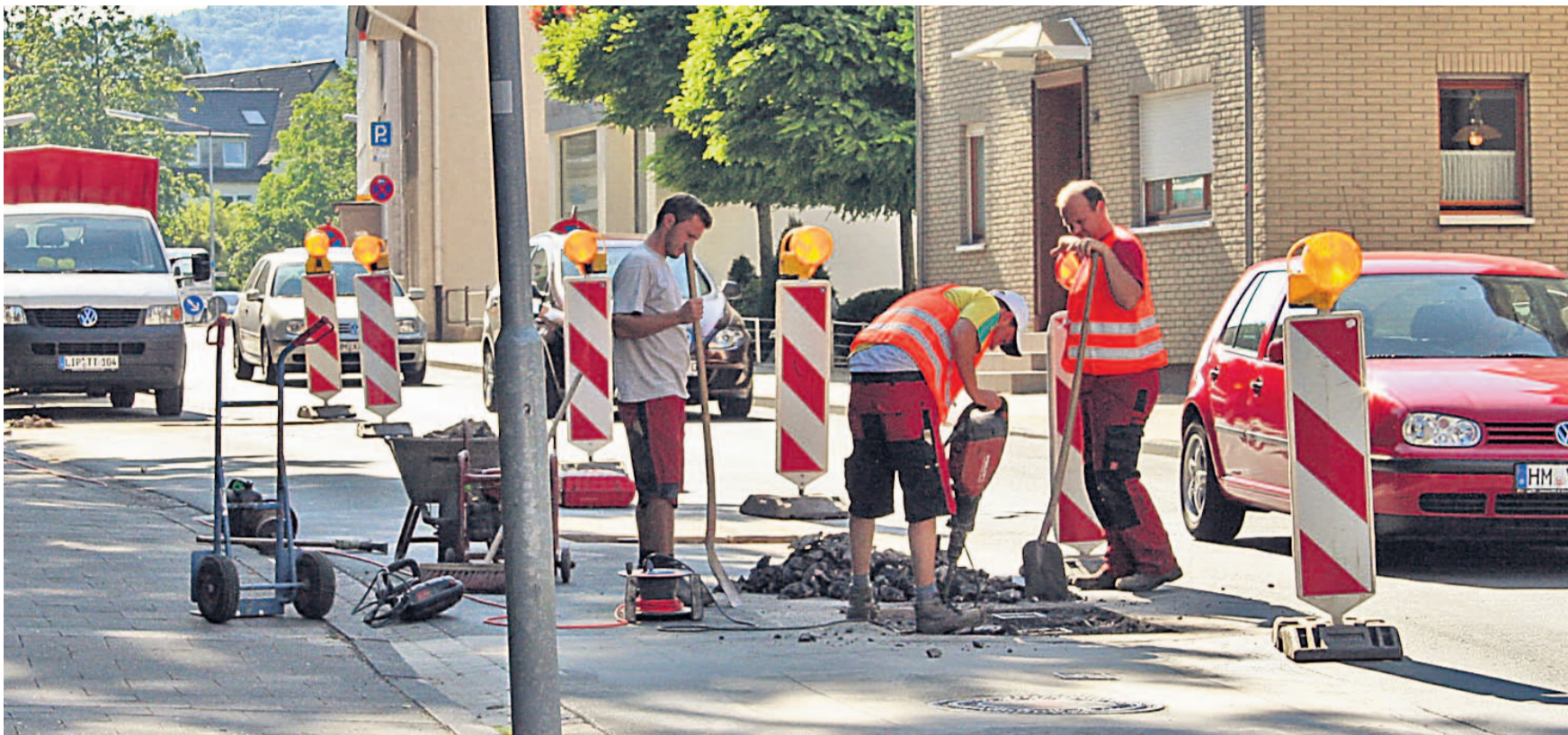
Die Reparatur der Winterschäden in der Lortzingstraße, mit der die Firma Trompeter am Dienstag begonnen hat, zählt die Stadt zu den größeren Maßnahmen. Fotos: uk/Stadt
