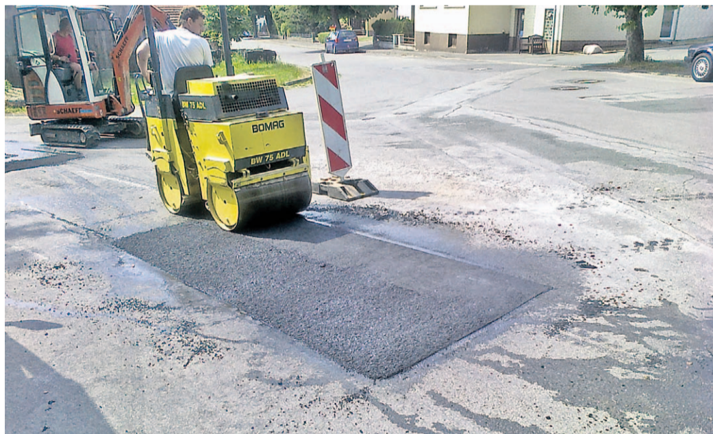
Vorarbeiten wie hier im Eichenbrink in Hagen hat der städtische Bauhof schon erledigt.
